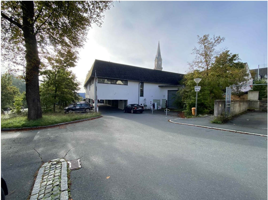
Rückwärtiger Gebäudeteil Anwesen Marktplatz 18 – 18c (Ansicht NW)
